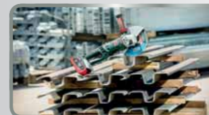
11 daraboló vágás szalagkorlátban Anyag: acéllemez
